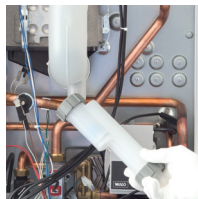
Rimozione sifone condensa
