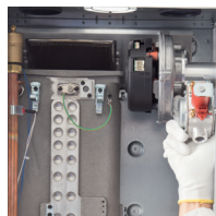
Rimozione del sistema di combustione completo
