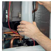
Rimozione collettore fumi
