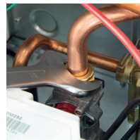
Rimozione del sistema di serraggio della tubazione
