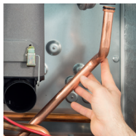
Rimozione del tubo gas
